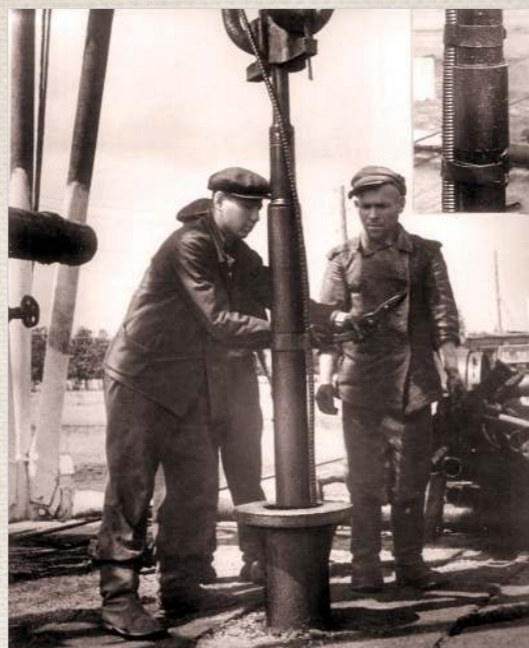
Монтаж погружного насоса в скважину
