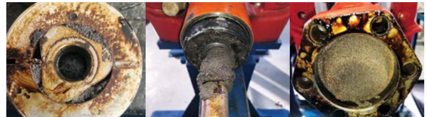
Рис. 10. Насос ОРНП, забитый механическими примесями после пробного запуска в Казахстане
