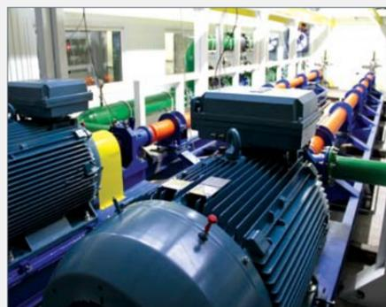
Подводящий трубопровод с байпасом для замены фильтров ФСС
