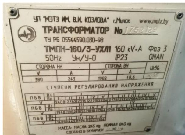
После ввода всех параметров в меню ТМПН, в пункте «Рекомендуемое напряжение отпайки» будет указано расчетное напряжение отпайки, которое рекомендуется выставить на ТМПН. На ТМПН нужно выставить ближайшее большее значение, это же значение необходимо ввести в параметре «Напряжение отпайки».
